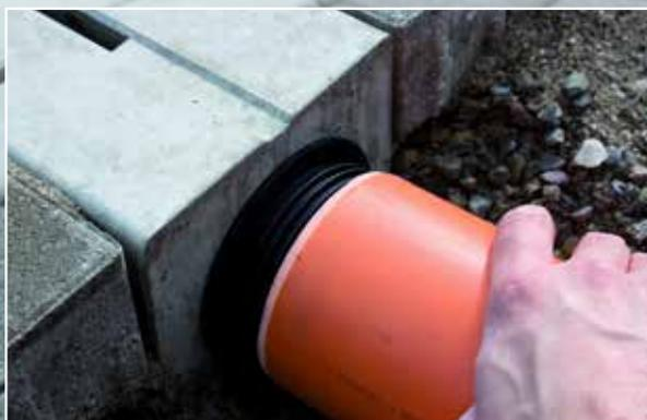
*Wenn flüssigkeitsdichte Entwässerung gefordert ist: Das innen liegende Dichtelement wird mit wenigen Handgriffen in den Stoß zwischen zwei Rinnen gesteckt und dichtet die Rinne zu 100 Prozent ab. Damit entfällt das zeitintensive Abdichten der Stöße mit dauerelastischen Massen. (Foto: Betonwerk Neu-Ulm)*
