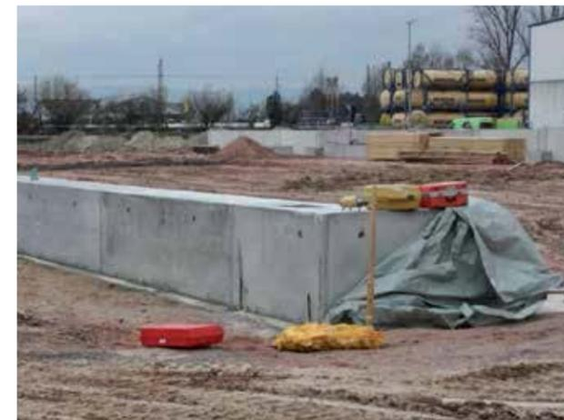
Standardmäßig ist die Schwerlast-Retentionsrinne mit einer Baulänge von 3,99 m. Lieferbar sind außerdem Passstücke und Winkelemente, die auf Wunsch individuell für die speziellen Gegebenheiten vor Ort hergestellt werden.
